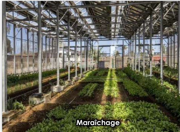
Serres photovoltaïques – Ile de la Réunion
